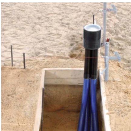
Bodeneinführung runde Ausführung
