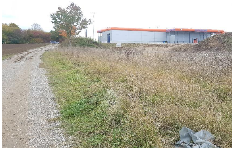
Abbildung 6: Waschanlage westlich des Geltungsbereiches (Blickrichtung Süden)
