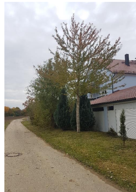
Abbildung 7: Gebäude und Gehölze westlich des Geltungsbereiches (Blickrichtung Süden)
