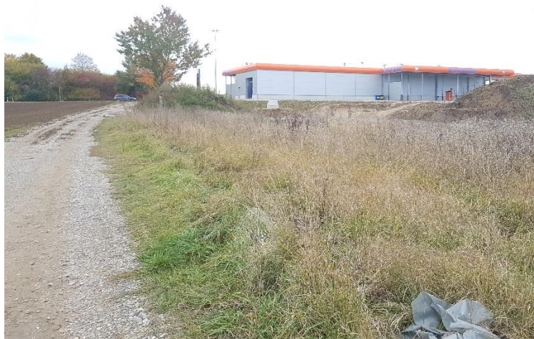
Abbildung 8: Waschanlage westlich des Geltungsbereiches (Blickrichtung Süden)
