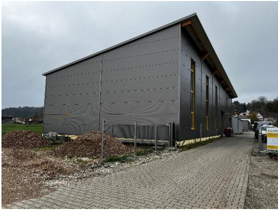
Abbildung 4: Lager- und Maschinenhalle
