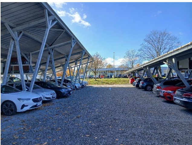
Foto 5: Umfeld Sondierbereich BS005
