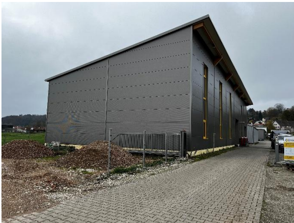
Abbildung 3: Lager- und Maschinenhalle innerhalb des Geltungsbereichs
